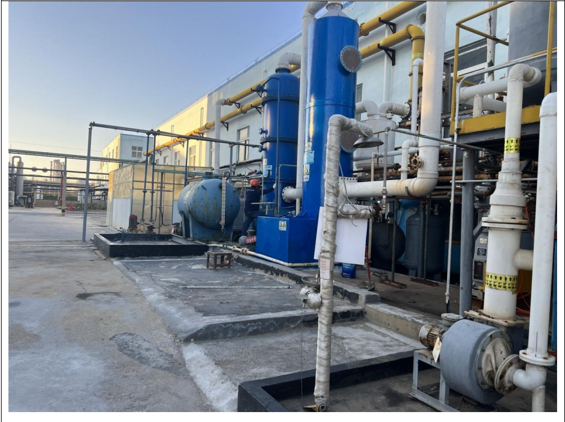
图 4-17 五车间现场情况
