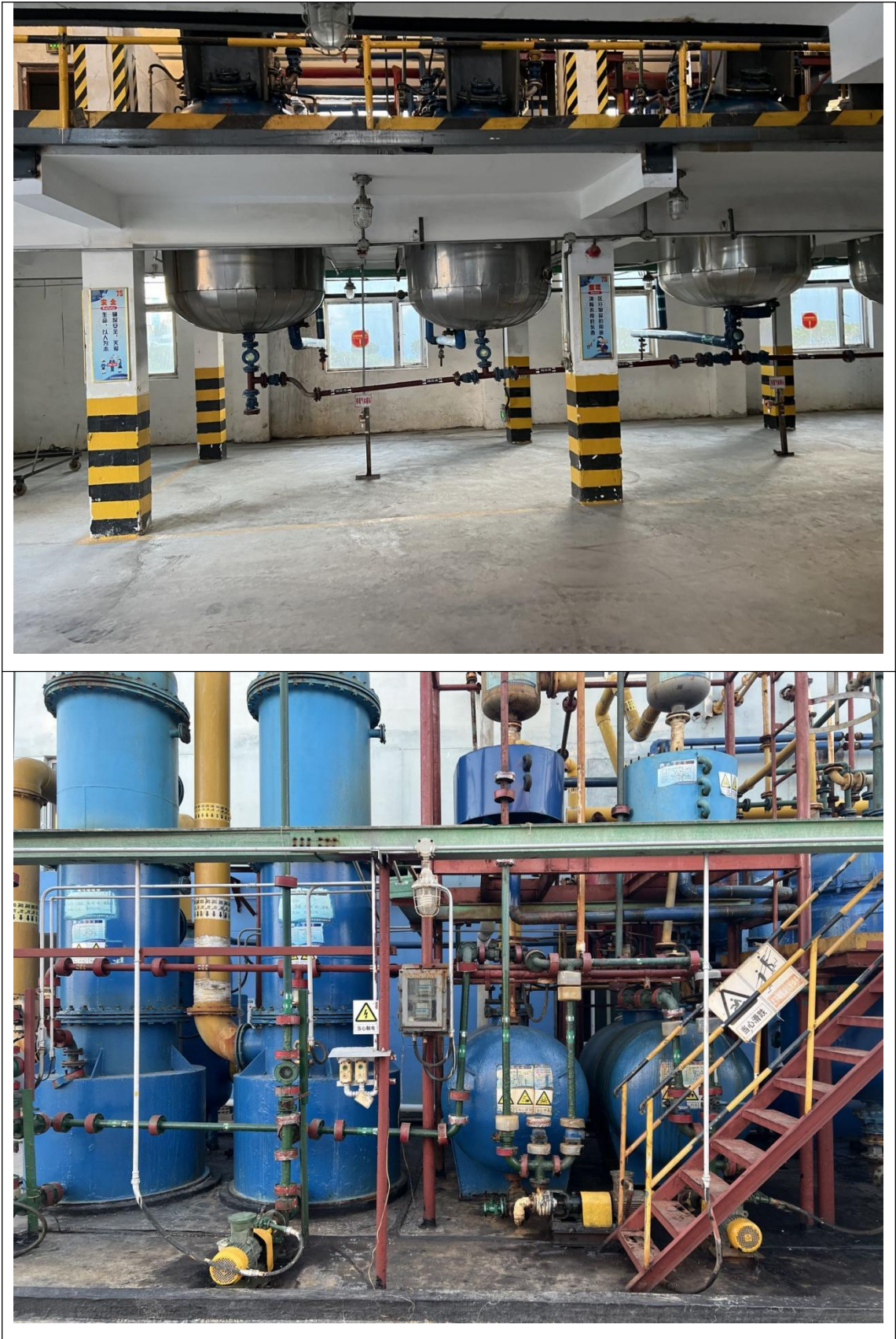
图 4-14 一车间现场情况
