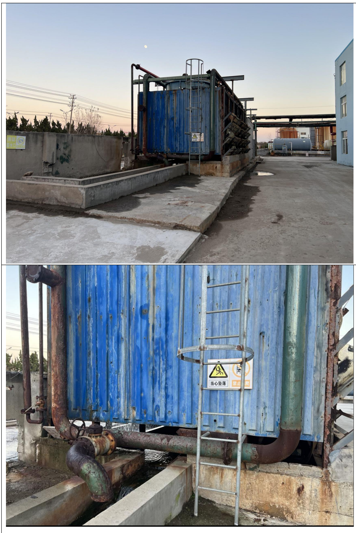
图 4-1 循环水池现场情况
