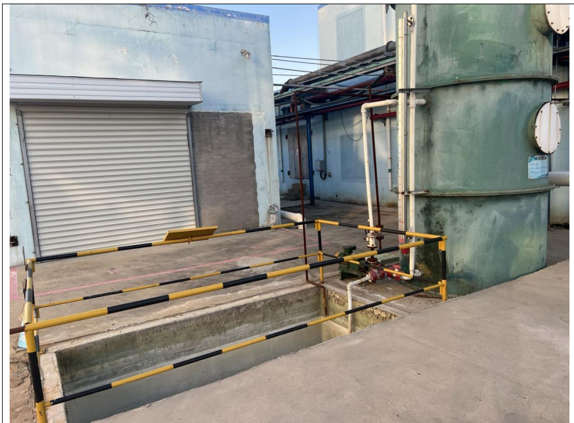
图4-3 事故应急池现场情况
