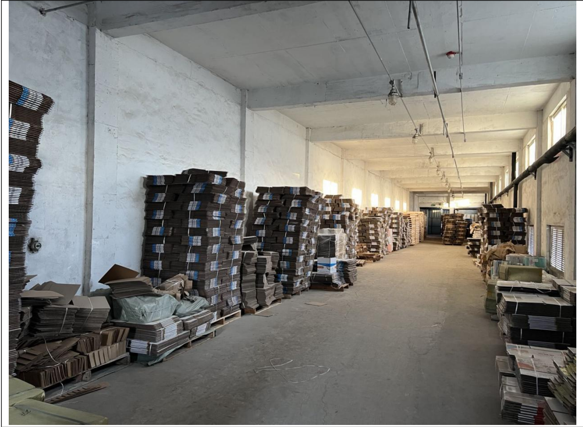
图 4-8 3#仓库现场情况
