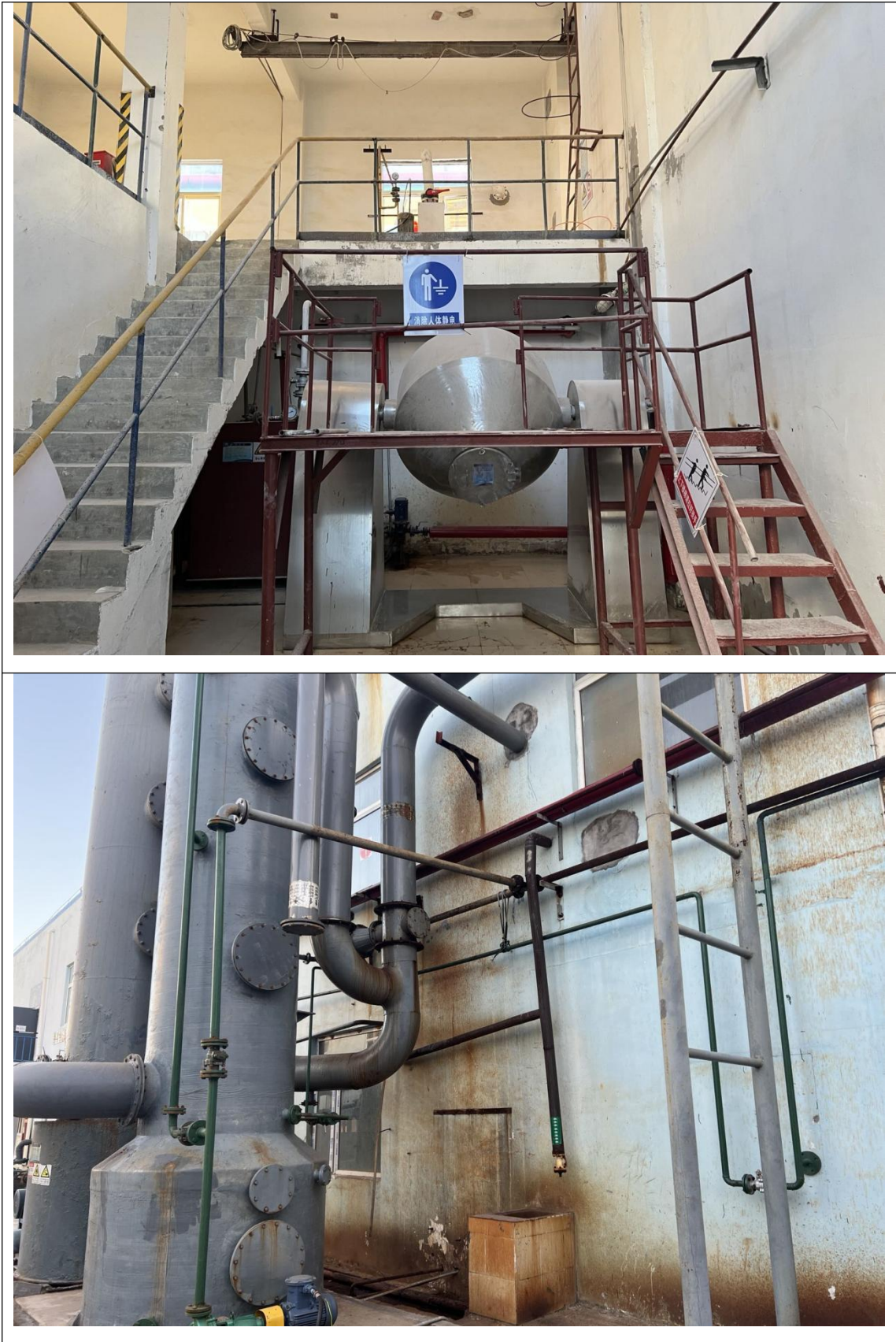
图 4-16 三车间现场情况
