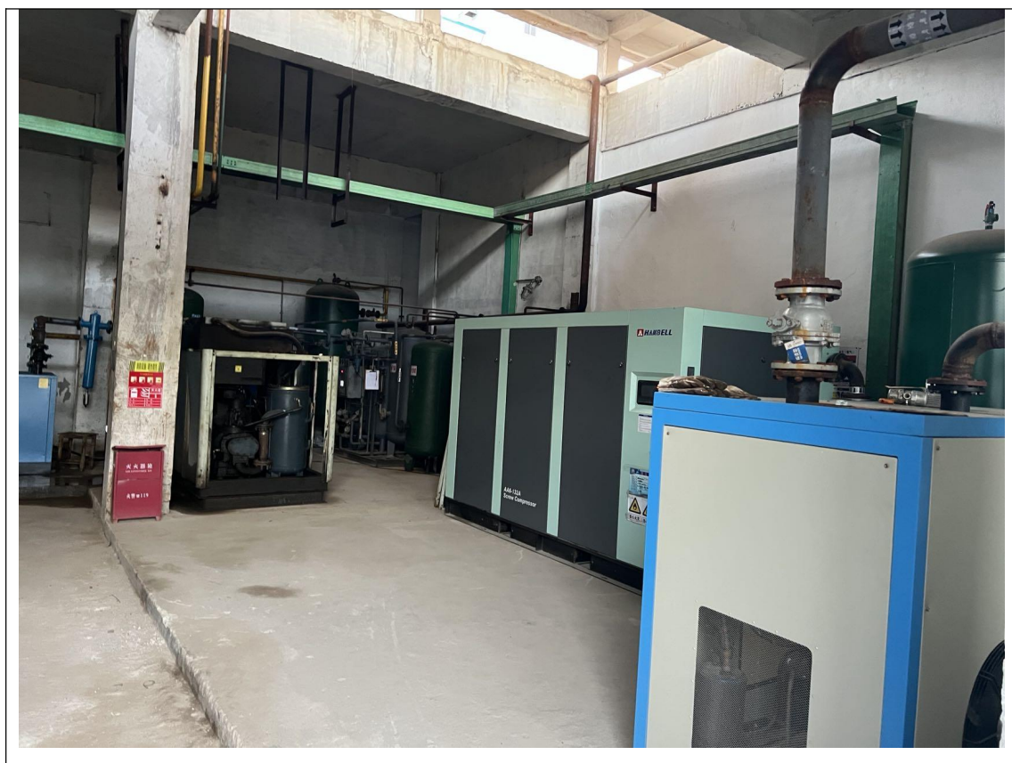
图 4-21 冷冻车间现场情况
