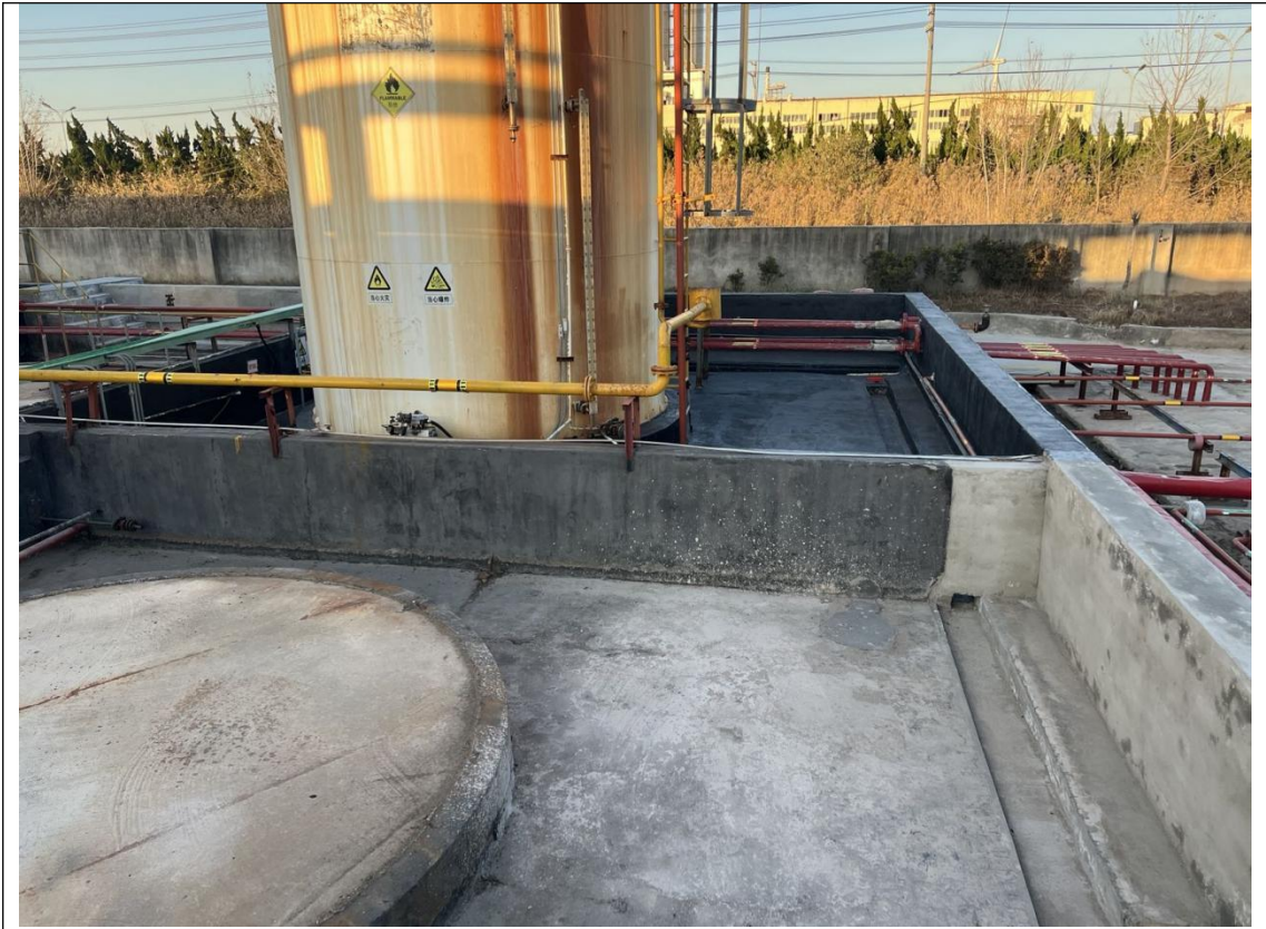
图 4-4 储罐区现场情况
